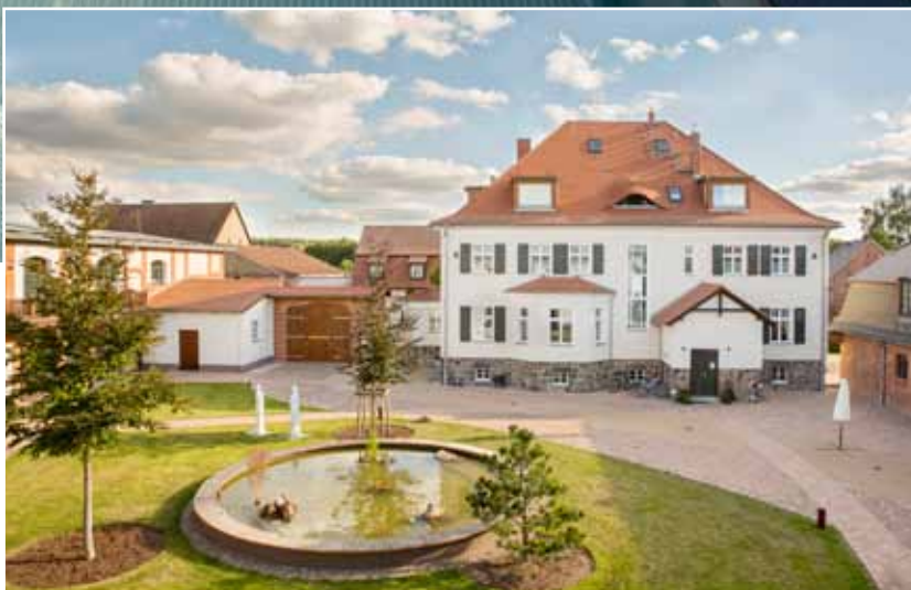
Der alte Vierseithof beherbergt nun ein modernes Seminarhotel mit Schwimmbad- und Wellnessanlage, die in der ehemaligen Scheune eingebaut ist. Stylisher Blickfang ist der Edelstahlpool. Im neu geschaffenen Obergeschoss sind jetzt Seminarräume untergebracht.
